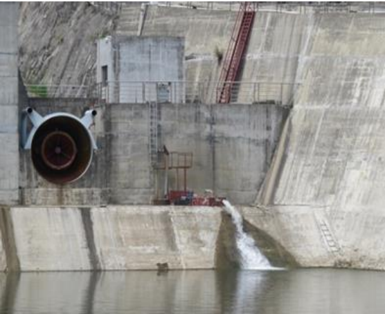
图 4.2-18 生态放水管设置情况
