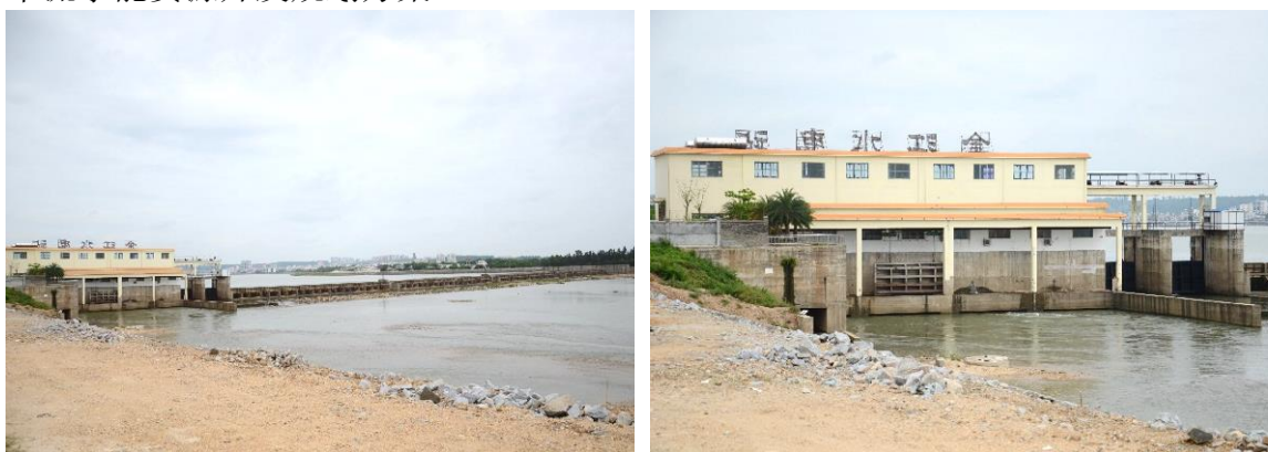
金江水电站大坝
