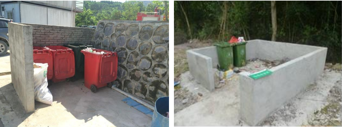
图 4.2-36 垃圾收集池及垃圾桶
