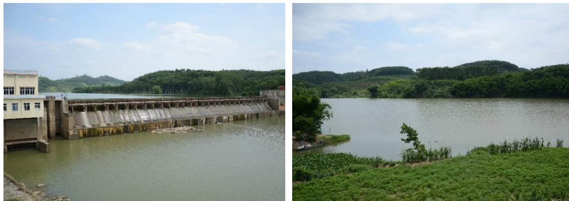
谷石滩水电站大坝
