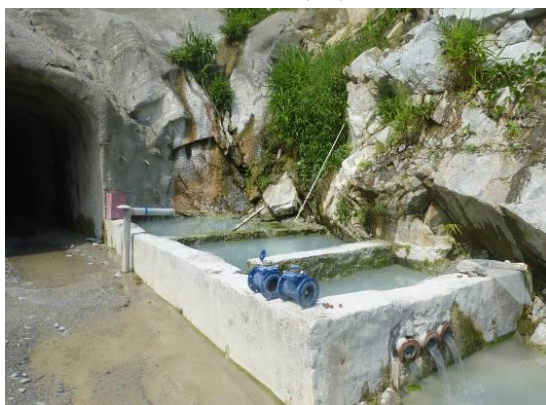
自流排水洞支洞口沉淀池
