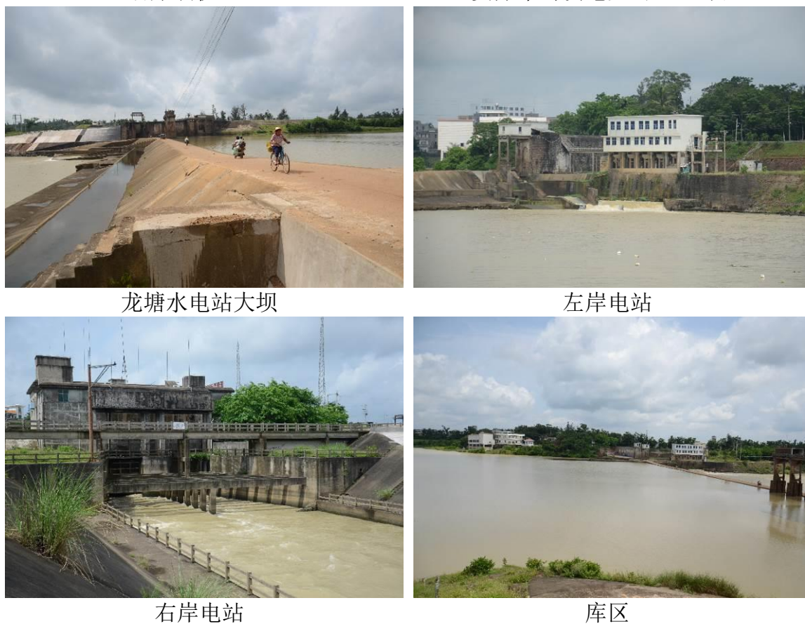
图 2.1-6 龙塘水电站现状面貌
