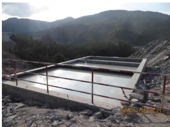
进厂交通洞废水沉淀池
