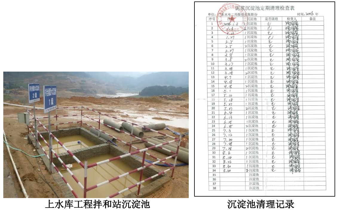
图 4.2-24 上水库混凝土拌合站沉淀池及清理记录
