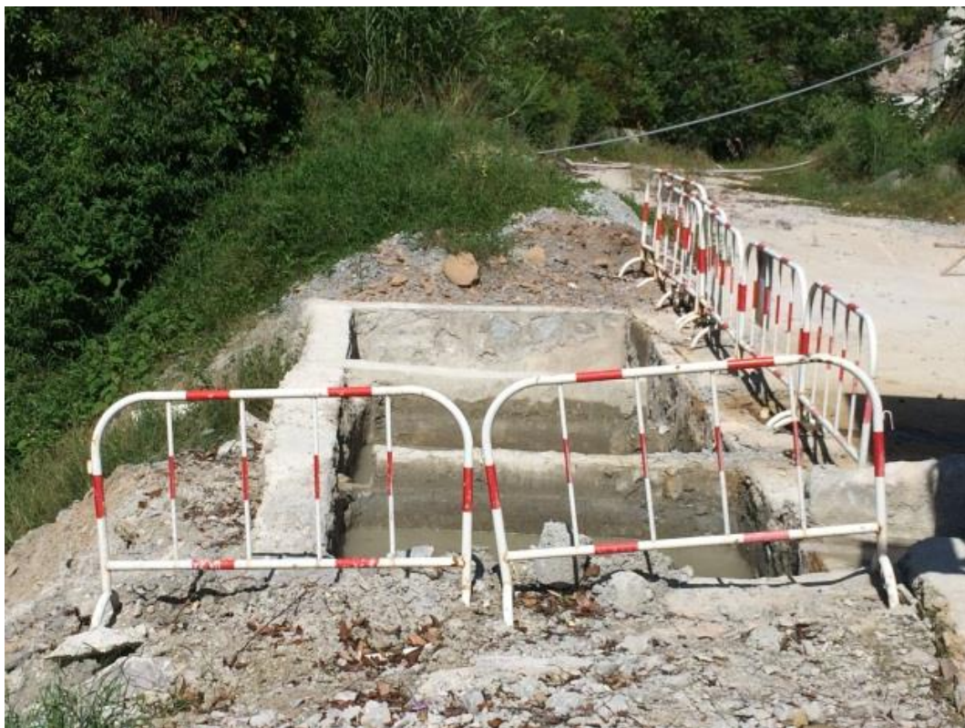
下水库右坝肩
