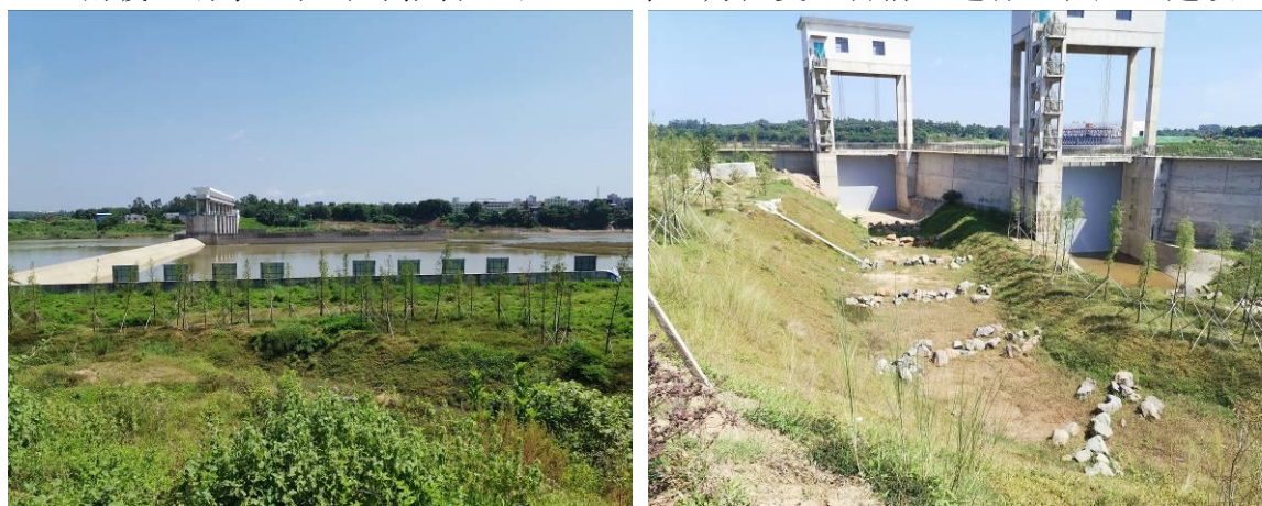
主体已建成的东山水库闸坝
