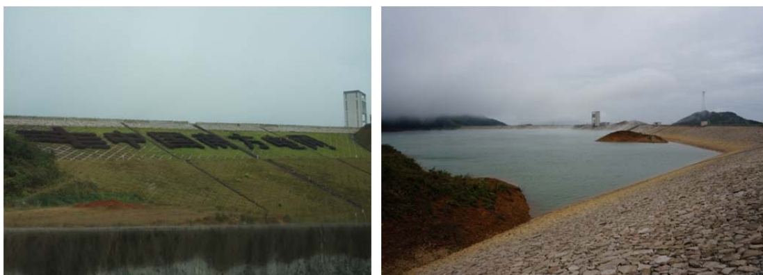
图 3.1-2 上水库现状照片2
