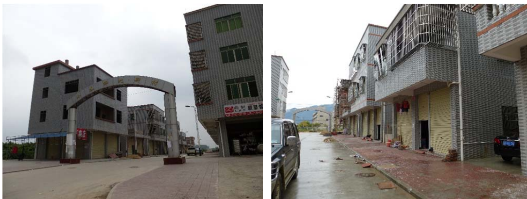
图 3.1-12 移民安置点2#（小秦桥北新村）
