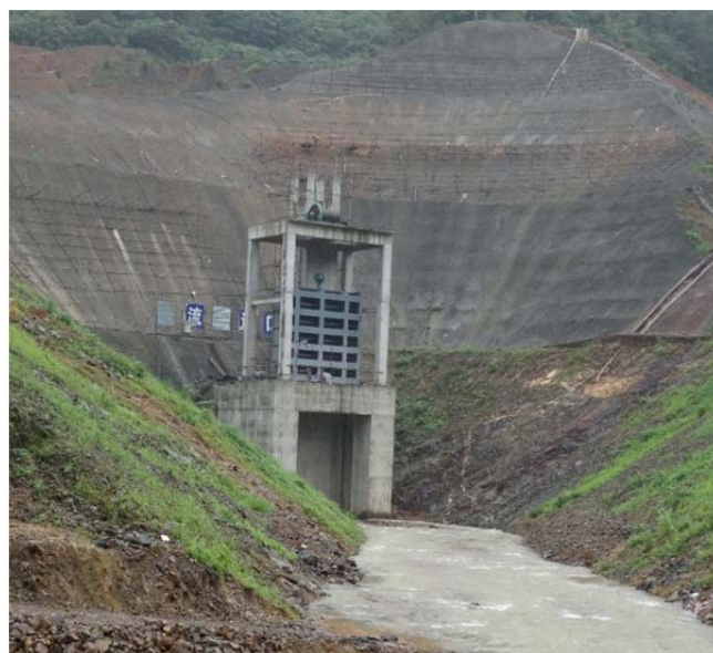
图 6.2-4 放水底孔现场照片
