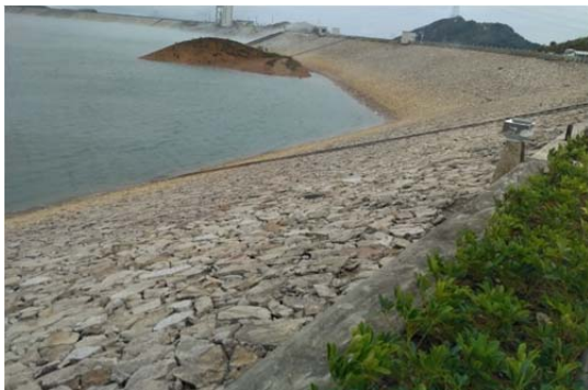
上库库区砌石护坡
