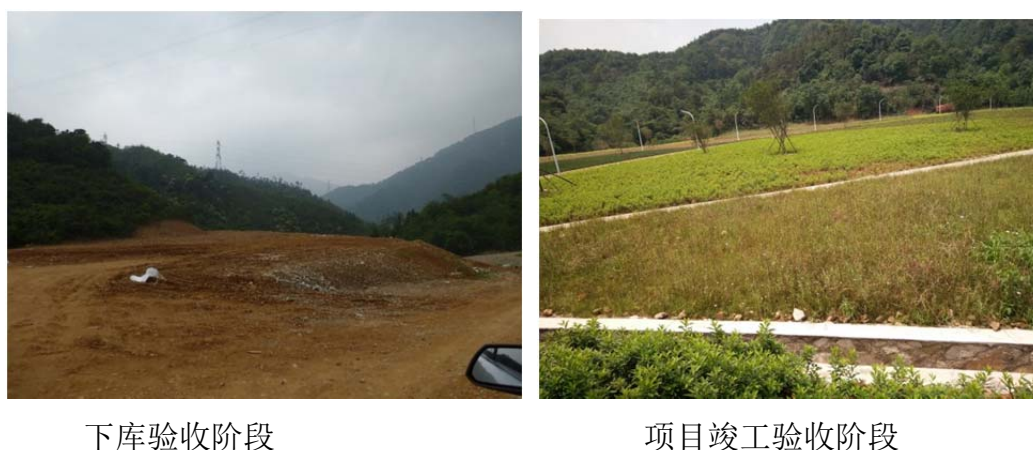
图 5.1-7 2#渣场现场图片
