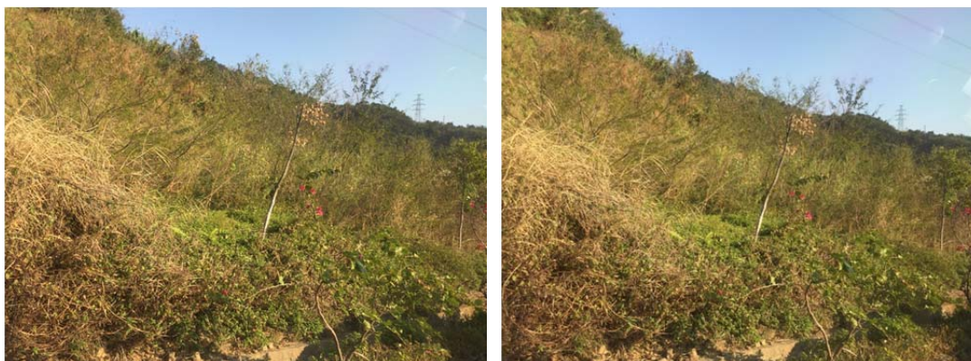
图 6.1-3 3#渣场现场照片
