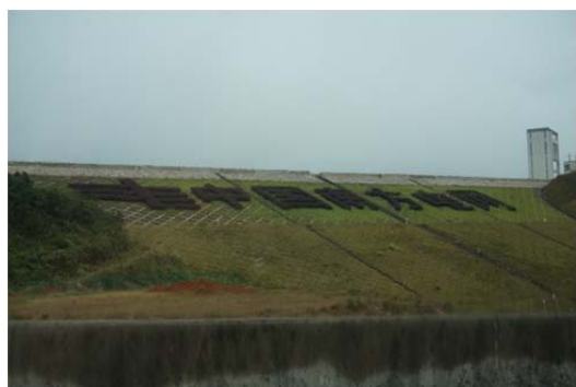
上库副坝二坝后景观
