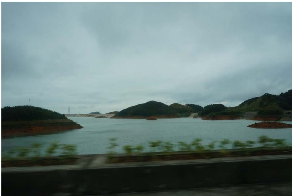
图 3.1-1 上水库现状照片
