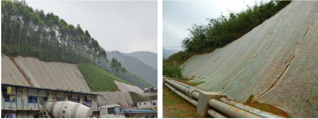
图 5.1-4 施工期水土保持临时措施——边坡临时覆盖
