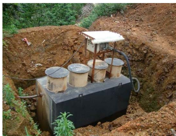
十四局营地地埋式成套污水处理装置
