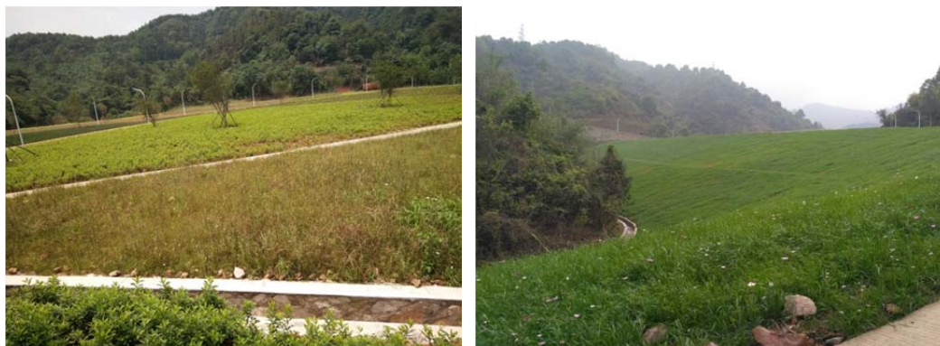
图 6.1-12 2#渣场现场照片
