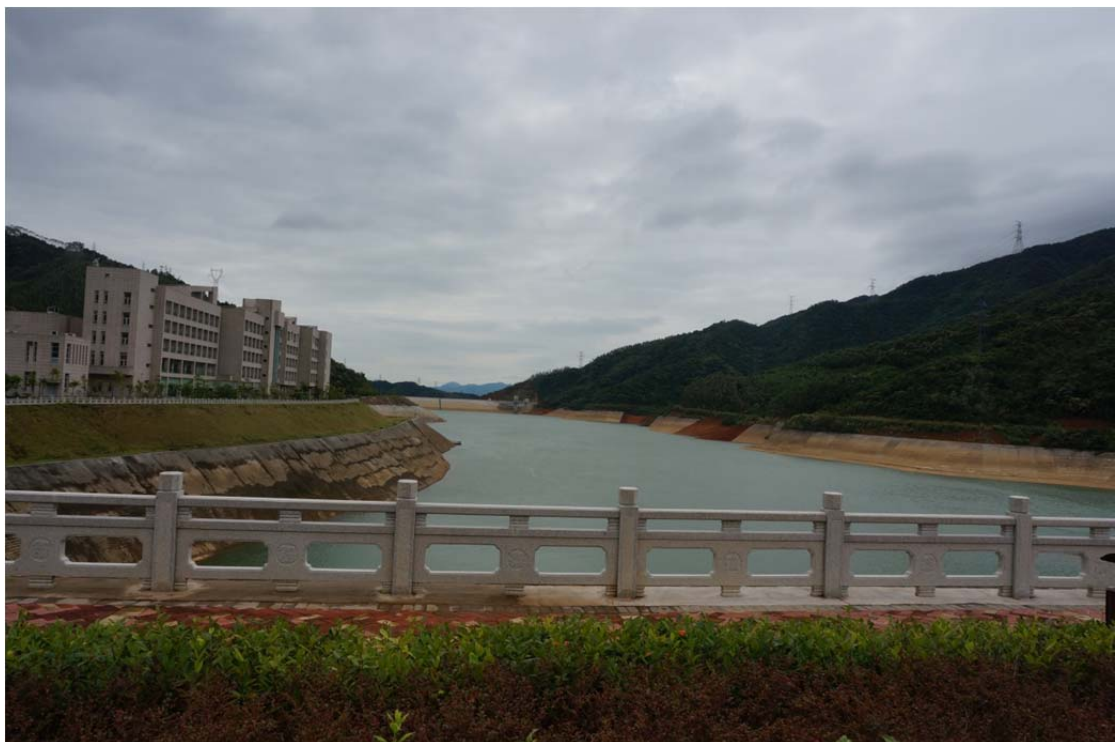
图 3.1-3 下水库现状照片
