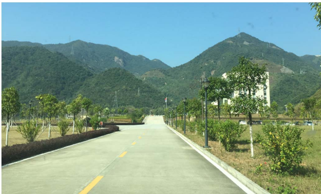
图 6.1-19 上下库连接公路边坡绿化现状照片
