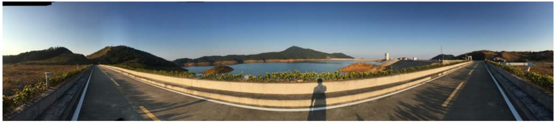
图 3.1-10 上库坝顶连接公路
