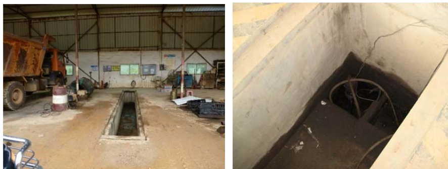
图 5.2-4 二局含油废水收集槽及隔油单元
