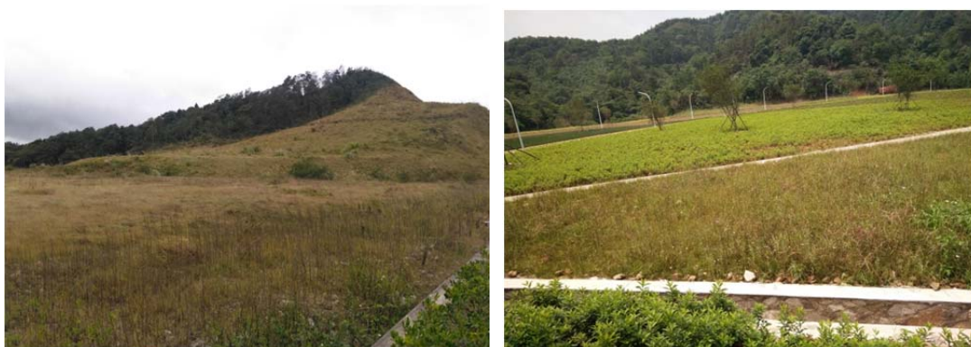
图 6.1-2 2#渣场现场图片
