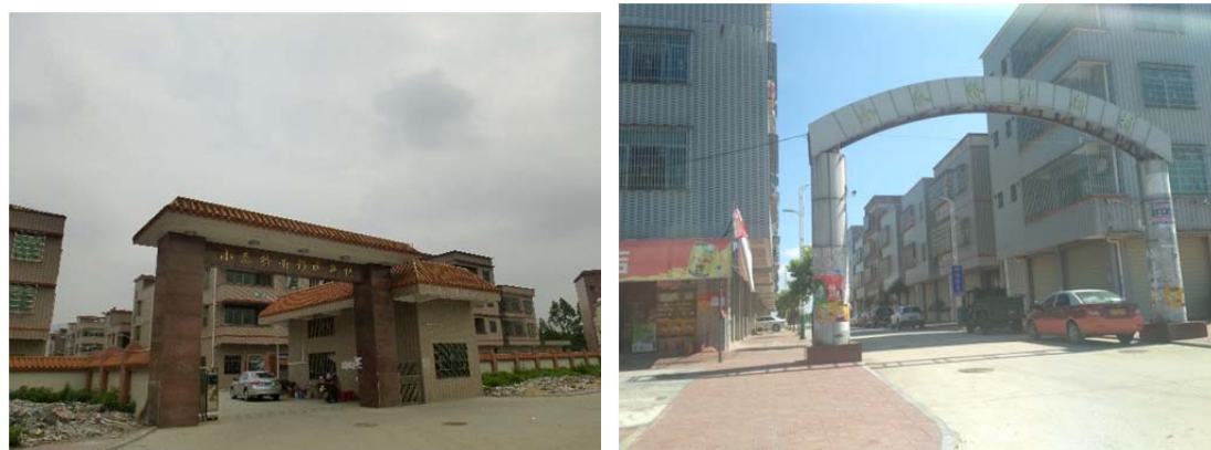
图 5.3-3 移民新村现场照片
