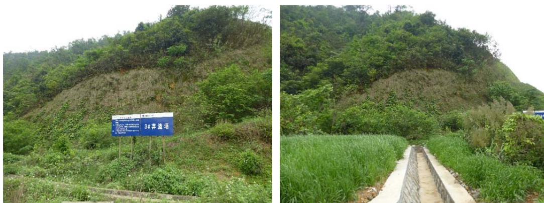
图 6.1-13 3#渣场现场照片
