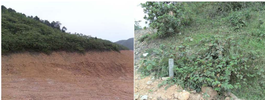
图 6.1-8 施工过程中施工区域边界标桩
