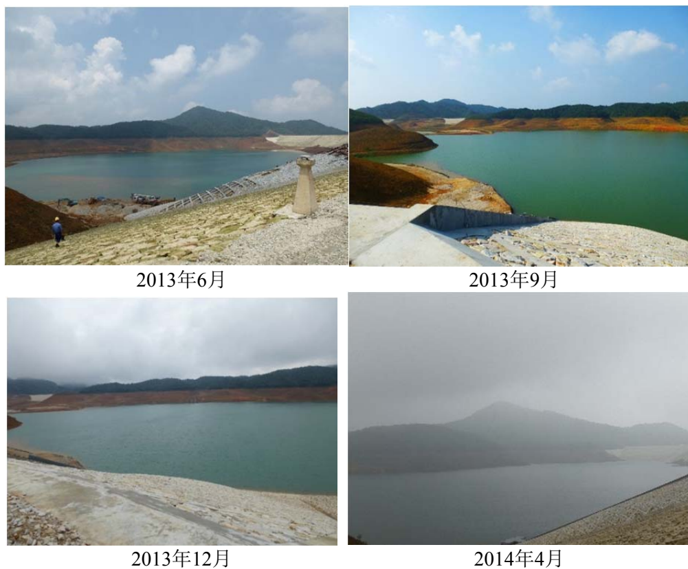
图 6.2-1 上水库蓄水过程照片
