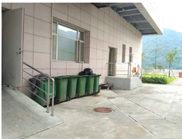
图 5-33 电站管理中心垃圾收集系统
