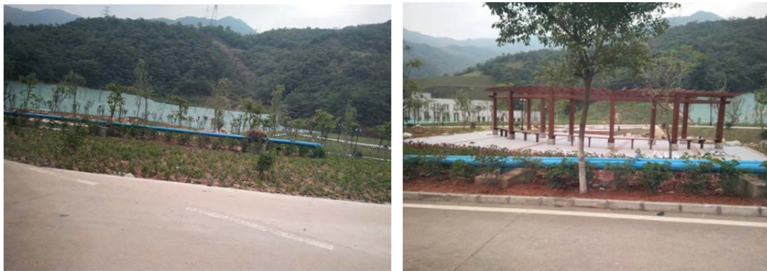
图 6.1-5 5#渣场现场照片
