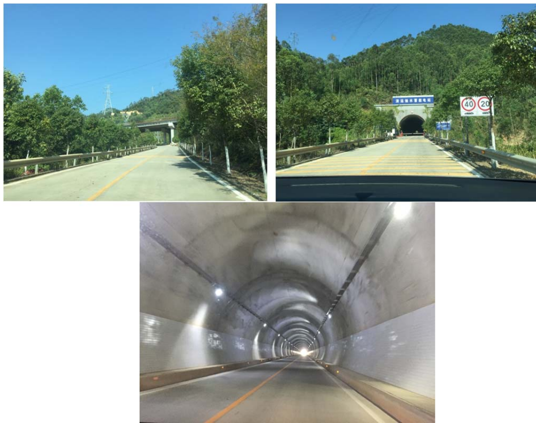
图 3.1-8 进场公路现场照片
