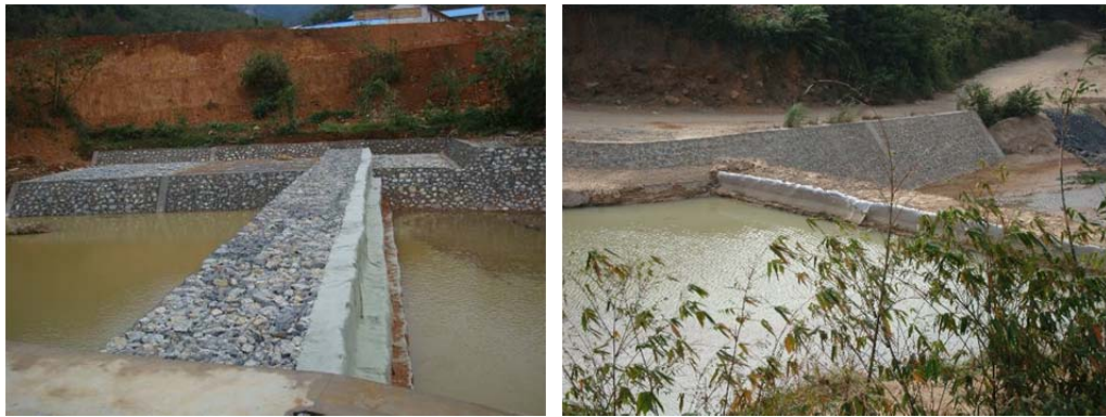
图 7.2-1 干砌石砂滤堰坝图
