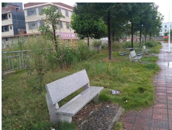
移民新村雨污分流系统
