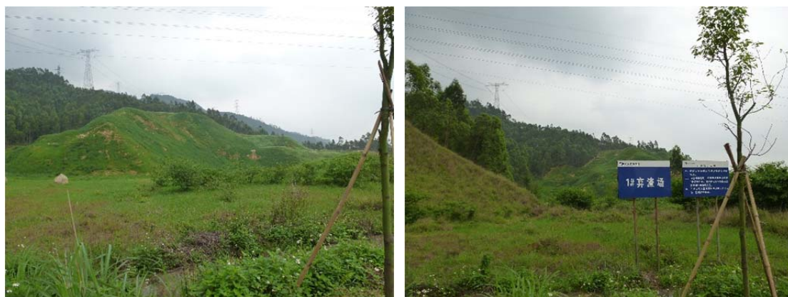
图 6.1-11 1#渣场现场照片
