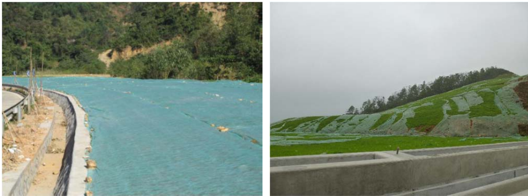
图 5.1-5 施工期水土保持临时措施之一——渣场临时覆盖
