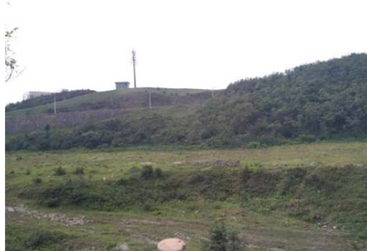
葛洲坝营地原址绿化
