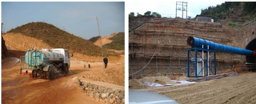
路面洒水降尘
