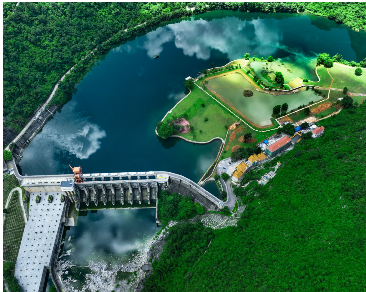
天生桥二级水电站
